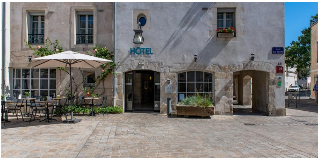
L'hôtel Saint-Nicolas reste ouvert pendant les travaux. Crédit : Cosy Hôtels
